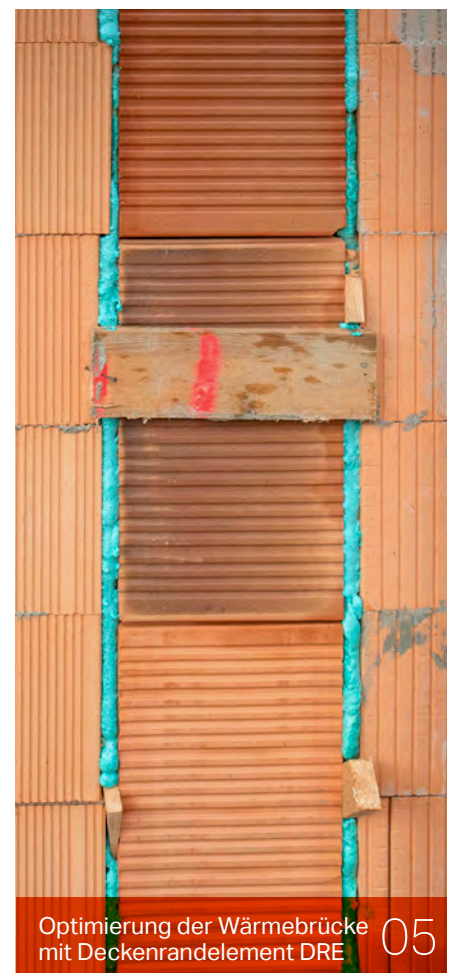
Setzen der mit Dünnbettmörtel benetzten Schalungsziegel
