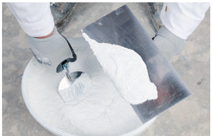
Verarbeitung des fertigen Oberputzes mit der Kelle
