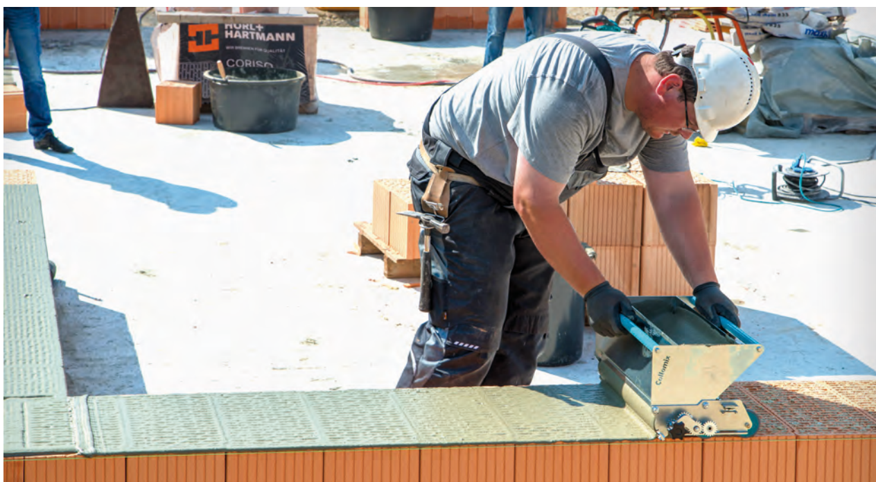
Auftragen des deckelnden Dünnbettmörtels durch Abrollen des Mörtelschlittens auf der Ziegelreihe
