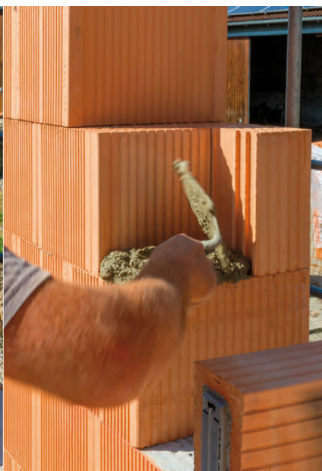
Einpassen des Formteils
