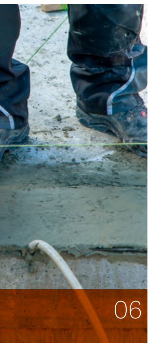
Die folgenden Steine der ersten Ziegelreihe werden an dieser Schnur ausgerichtet und deren Position mit der Wasserwaage kontrolliert. 07
