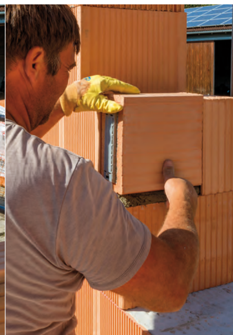
Setzen des Gurtwicklers
