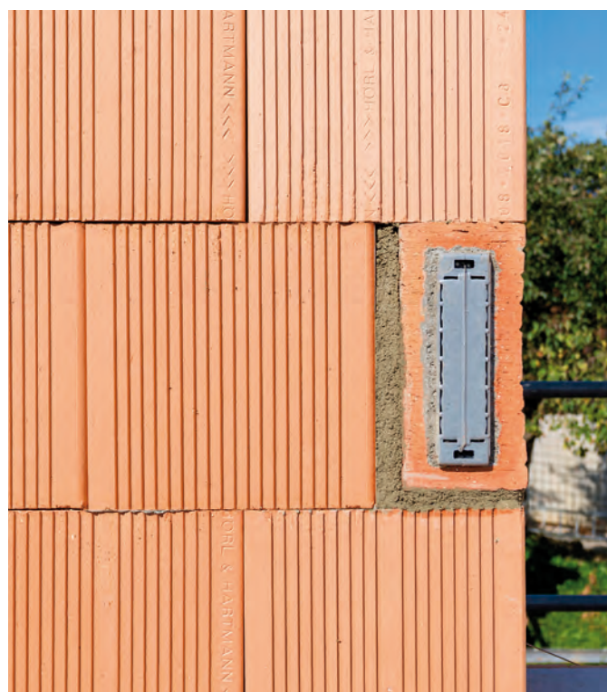
Ins Mauerwerk integrierter Gurtwickler-Formziegel
