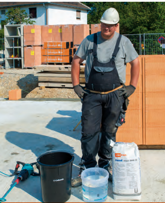
Werkzeug und Mörtel vorbereiten
