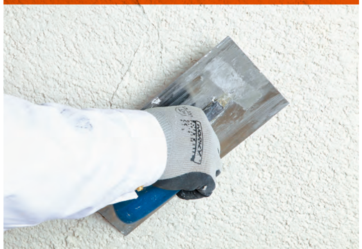
Strukturieren des Oberputzes mit der Glättkelle
