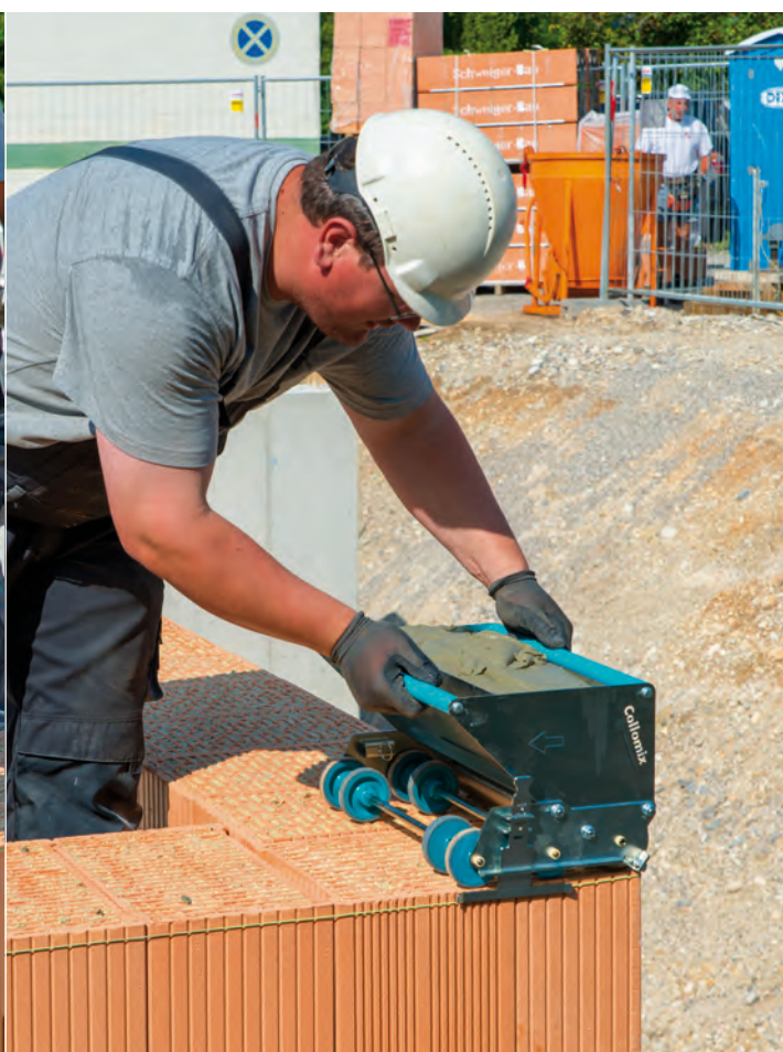
Ansetzen des Mörtelschlittens an der Kante
