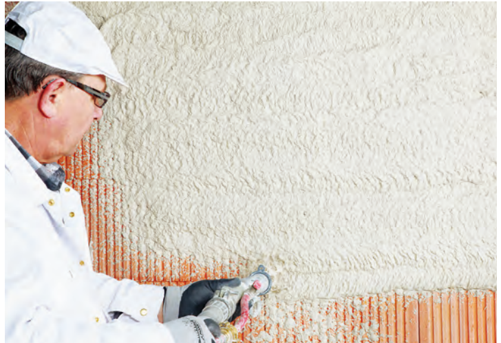
Auftrag des Unterputzes auf Planziegelmauerwerk
