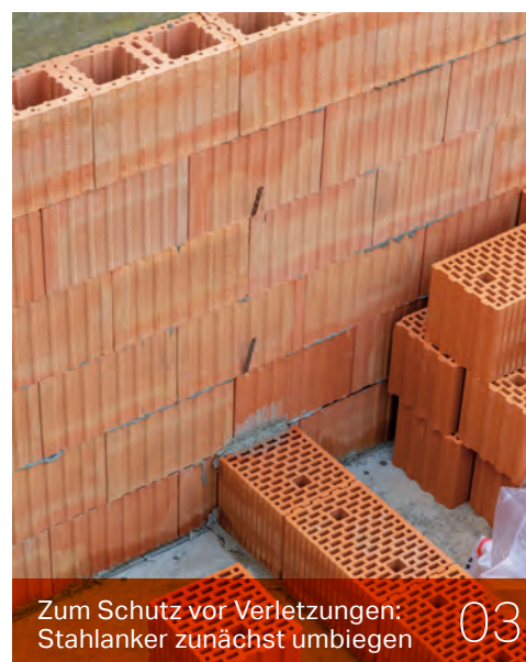
Einlegen der Flachstahlanker in den Dünnbettmörtel 01
