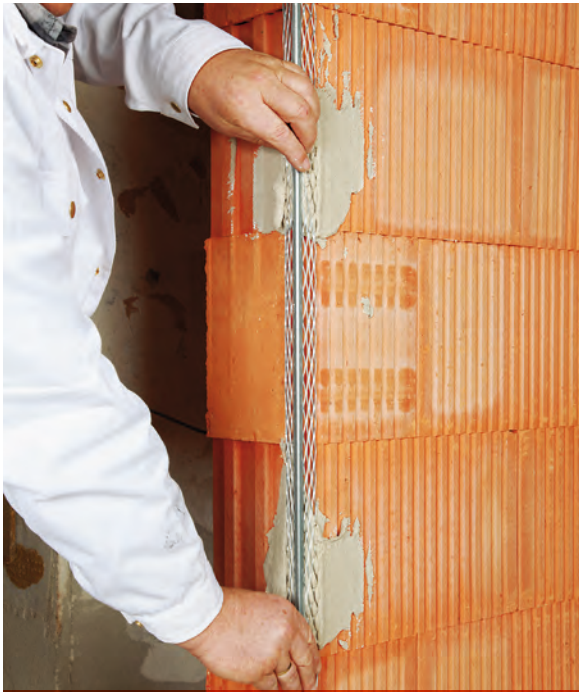
Setzen der Eckschutzschienen
