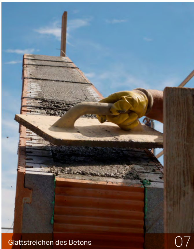
Ergebnis: Ringanker als optimierte Wärmebrücke
