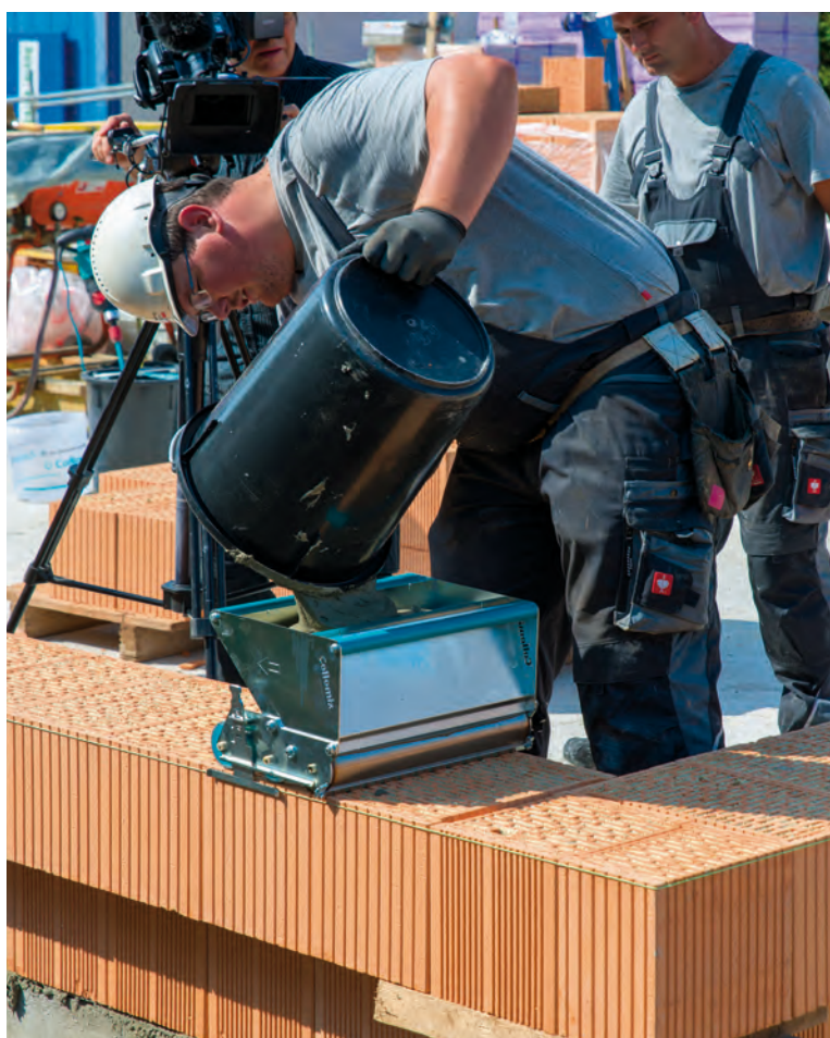
Befüllen des Mörtelauftragsgerätes
