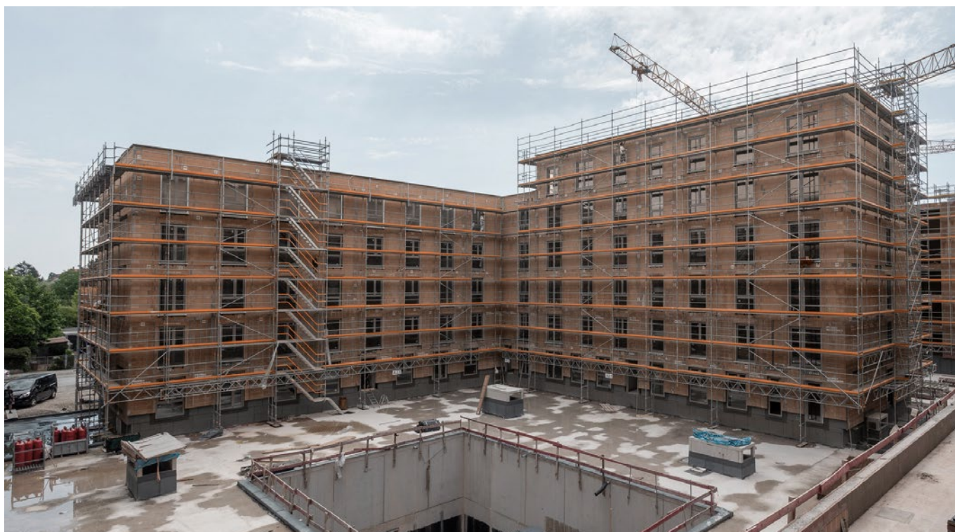
McGraw – ein gigantisches Bauprojekt in monolithischer Bauweise: Systemlösungen von Ziegelblenden bis hin zu Rollladenkästen mit integrierter Lüftung.
