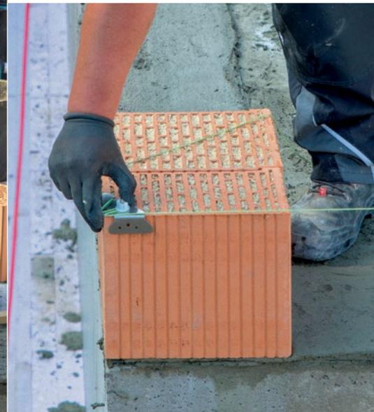
Eine waagrechte Schnur verbindet den ersten Ziegelstein mit dem zweiten Stein am Ende der zu errichtenden Mauer.
