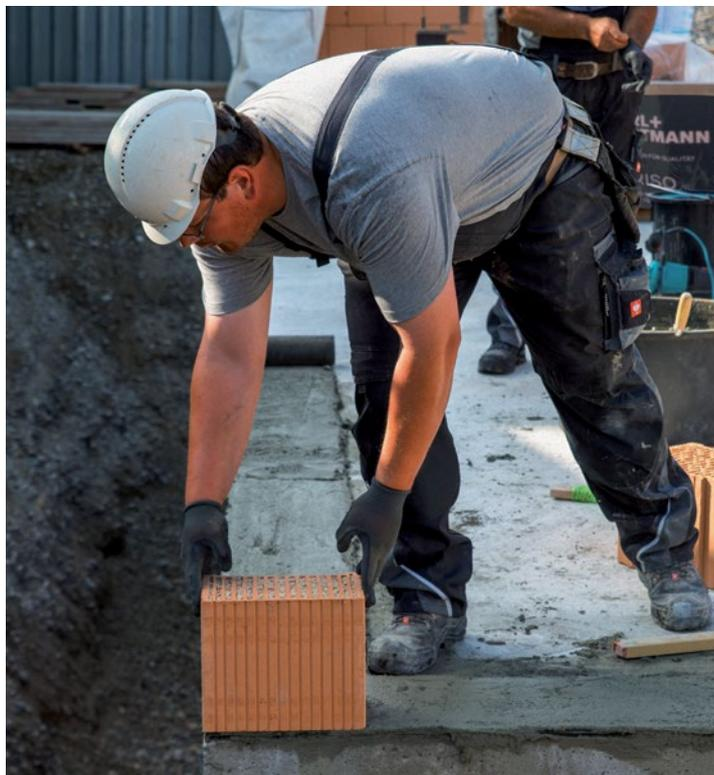
Sobald die Anlegesicht mit Horizontalsperre (Bitumenbahn) fertiggestellt ist, wird der erste Ziegelstein aufgelegt und mit leichtem Anklopfen ins Wasser gestellt.
