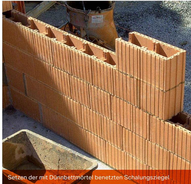
Setzen der mit Dünnbettmörtel benetzten Schalungsziegel
