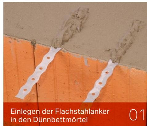
Einlegen der Flachstahlanker in den Dünnbettmörtel 01
