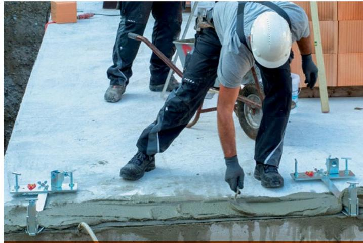
Die beiden Anlegehilfen werden im Abstand der Abziehschiene / Wasserwaage so ausgerichtet, dass jede für sich im Wasser liegt und die Anlegehilfen zueinander eine waagrechte Ebene (Planarität) bilden. Es ist darauf zu achten, dass diese Schicht nicht mehr als 3 cm über die ganze Länge des Bauwerks ausgleicht.
