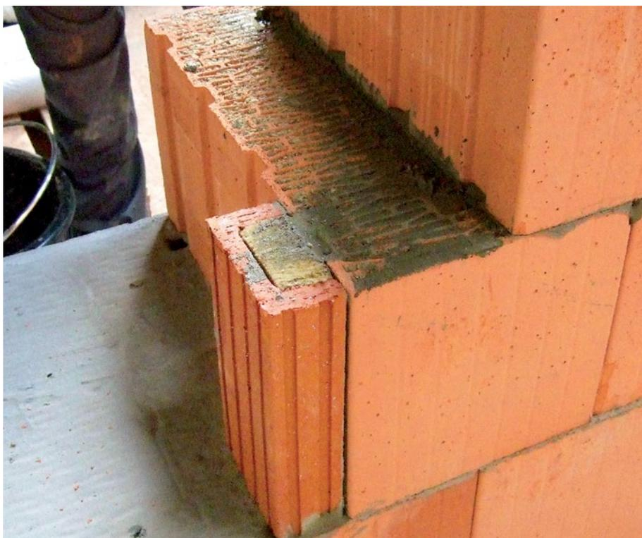
Die Fensteranschlagschale wird flächig mit Dünnbettmörtel auf der dämmstoffgefüllten Seite benetzt und an die Fensterlaibung bzw. den Sturzbereich angemörtelt. Im Laibungsbereich kann eine zusätzliche Bewehrung mit Flachstahlankern für eine kraftschlüssige Verbindung und somit für erhöhte Stabilität sorgen.
