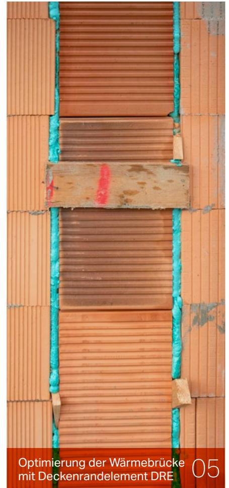
Optimierung der Wärmebrücke mit Deckenrandelement DRE
