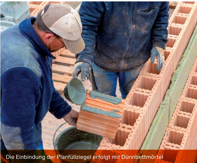
Im Gegensatz zu den voran gezeigten Wohnungstrennwänden sind Kommunwände aus Beton verfüllten UNIPOR-Planfüllziegel doppelwandig aufgeführt. Durch die großen Massen erfüllt diese Wandkonstruktion einen bestmöglichen Schallschutz. Gleichzeitig führt die doppelwandige Ausführung mit einer Trennschicht aus Dämmmaterial zu einer effizienten akustische Entkopplung der beiden Wohneinheiten.
