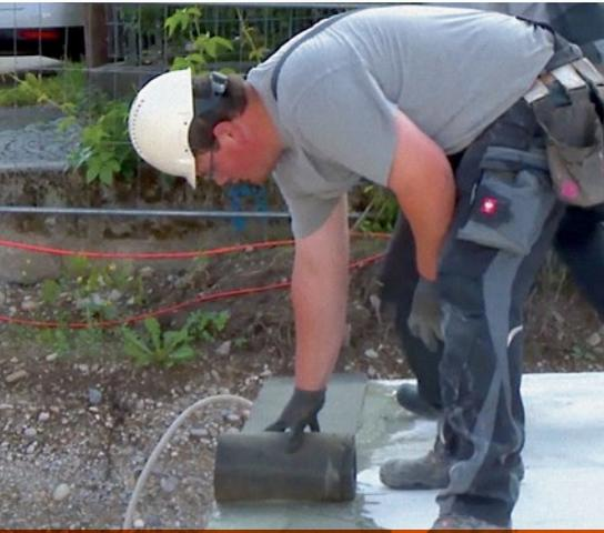
Die wasserundurchlässige Bitumenbahn wird dort auf einer dünnen Mörtelschicht (maxit therm 825) ausgerollt, wo später das Mauerwerk errichtet werden soll.
