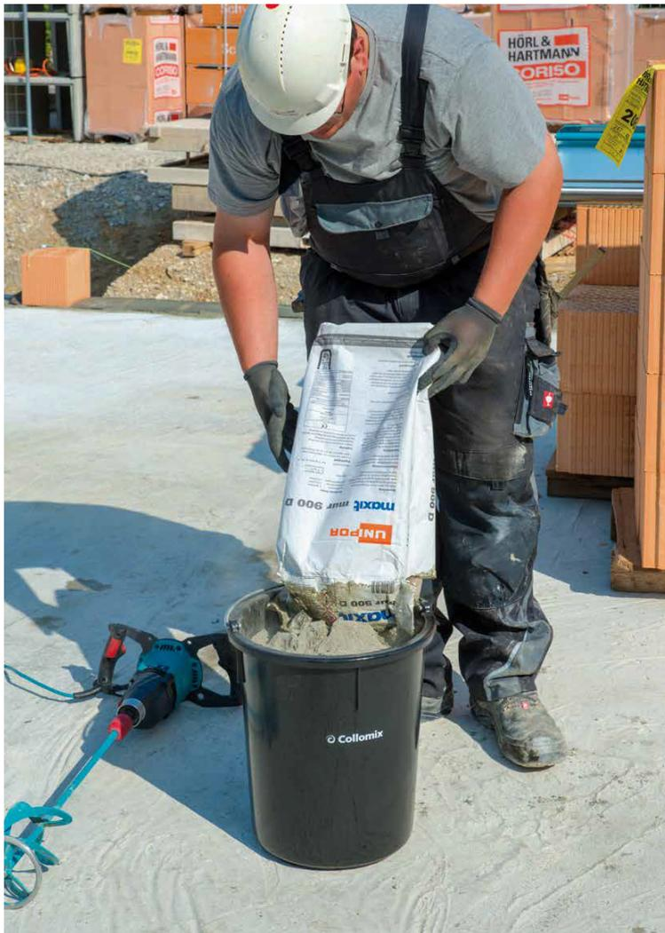
Planziegel, gefüllt oder ungefüllt, sind entsprechend dem Leistungsbeschreibung und dem Zulassungsbescheid mit Dünnbettmörtel (z.B. maxit mur 900D) gedeckelt nach DIN EN 1996 zu vermauern.
