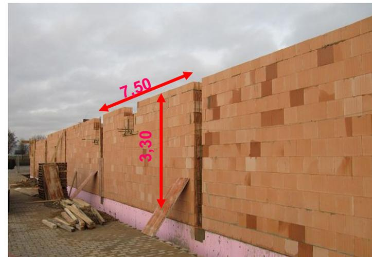
Ausfachungen mit Mauerwerk im Industrie- und Gewerbebau.
