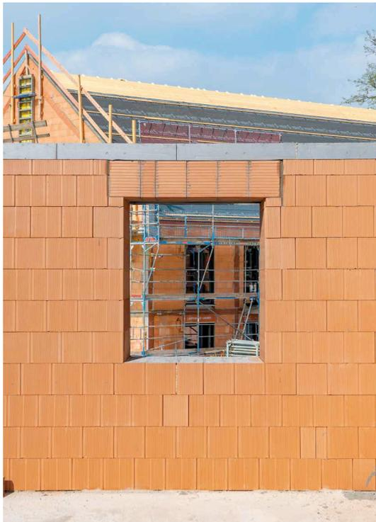
Vorgefertigte Flachstürze werden zur Überdeckung von Wandöffnungen in tragenden und nichttragenden Wänden verwendet. Die Tragfähigkeit wird durch das Zusammenwirken der Sturzfertigteile mit dem darüber liegenden Mauerwerk erreicht.
