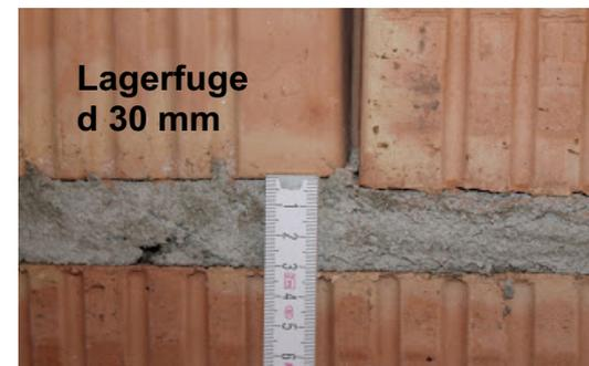
Bei **Fugendicken  $\geq 20$  mm** sollte man aufgrund der vorliegenden Versuchsergebnisse nach Grafik eine Abminderung der Drucktragfähigkeit von bis zu 50 % ansetzen.
