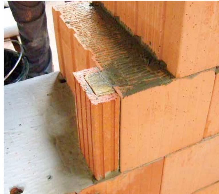
Die **Gurtwickler-Formziegel**, können wie ein Halbstein in der Laibung verbaut werden. Sie sind wärmedämmend und auf fünf Seiten luftdicht.
