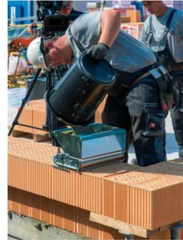
Befüllen des Mörtelauftragsgerätes und ansetzen des Mörtelschlittens an der Kante
