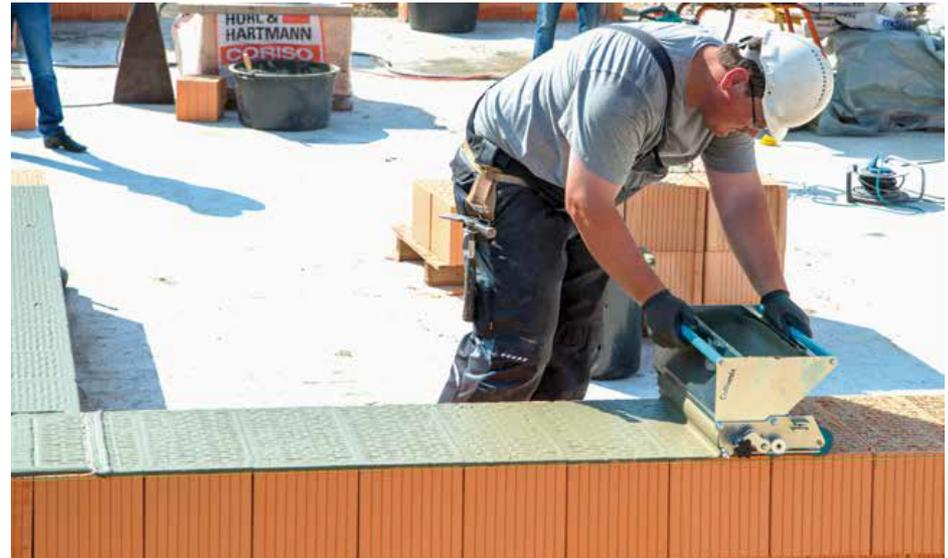
Auftragen des deckelnden Dünnbettmörtels durch Abrollen des Mörtelschlittens auf der Ziegelreihe
