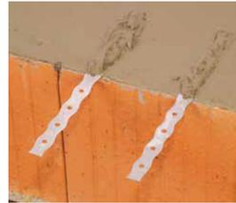
Einlegen der Flachstahlanker in den Dünnbettmörtel.
