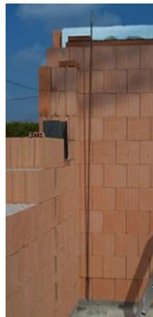
Mauerwerk wird „hinter“ Zuganker erstellt!
