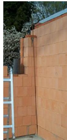
Zuganker ca. 3 cm tief in die Außenwand einschlitzen.
