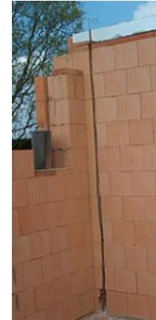
Zuganker in Schlitz mit LM 21 vermauern (mit Quernägeln sichern) und mit Gewebe überspannen
