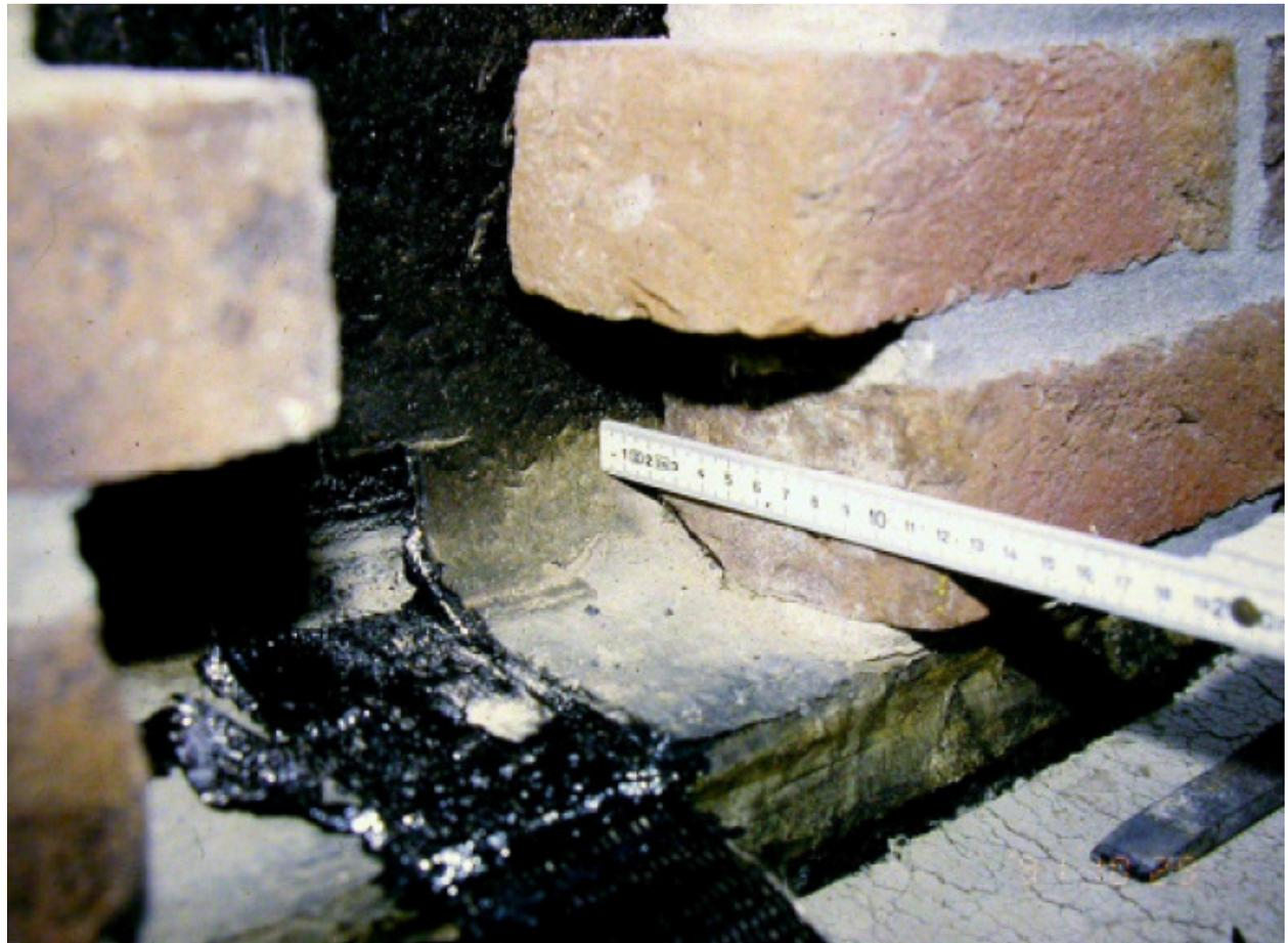
Im Gefälle verlegte Fußpunktabdichtung lässt die Verblendschale rutschen
