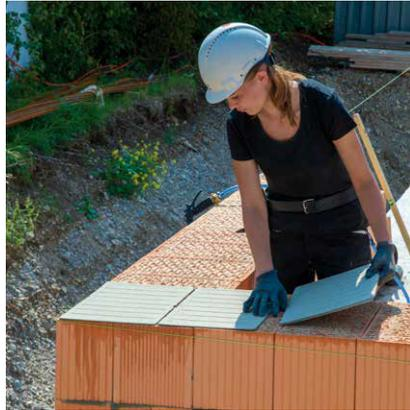
Trockene MörtelPads bündig auflegen
