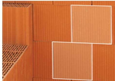
für **Elementmauerwerk** mit Steinhöhen  $h_u \geq 374$  und/oder Steinlängen  $l \geq 498$  mm gilt ein **Überbindemaß**:
