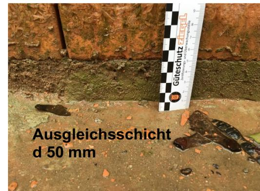
Vereinzelte Abweichungen von der Fugen-Solldicke lassen sich nicht vermeiden. Sie sind tolerierbar für eine Lagerfugendicke im Bereich von 5 bis 20 mm und eine Stoßfugen-dicke im Bereich von 5 bis 15 mm, wenn jeweils die Fugen- Solldicke im Mittel eingehalten wird. (Dies gilt nicht für Sicht-mauerwerk!) (Schubert)
