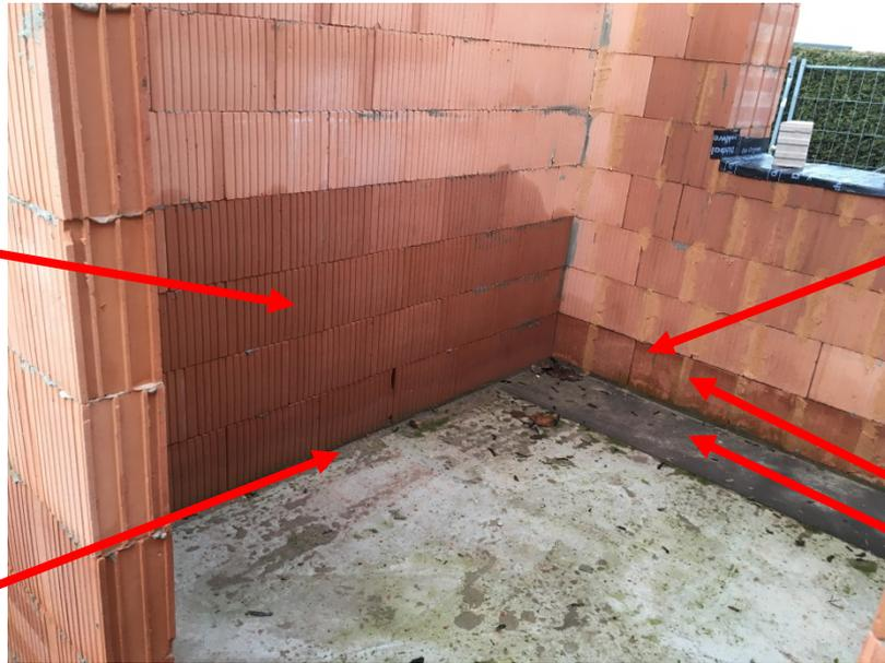
Durchfeuchtung der Steinschicht aus Tagwasser das auf der Bodenplatte / Decke anfällt.
