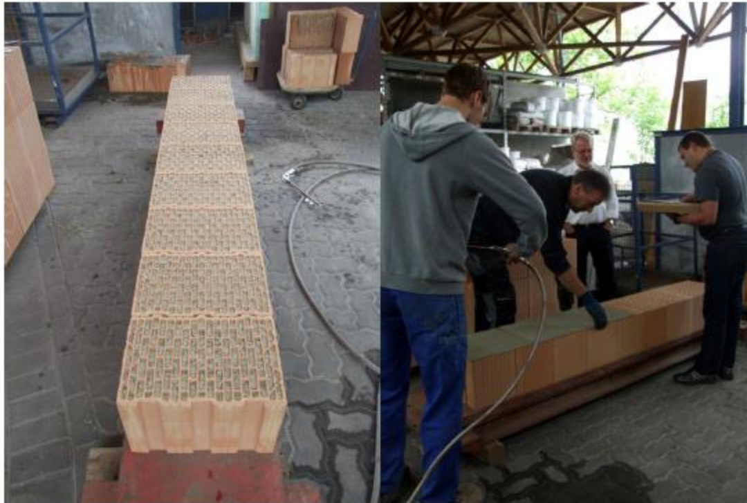
Bild 9: Setzen der ersten Stein- bzw. Mörtellage
