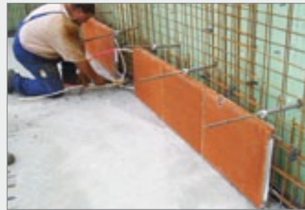
Vorbereitung zum Einbau in den Betonkeller
